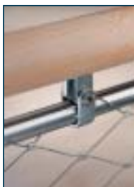
Befestigung Rahmen an Handlauf
