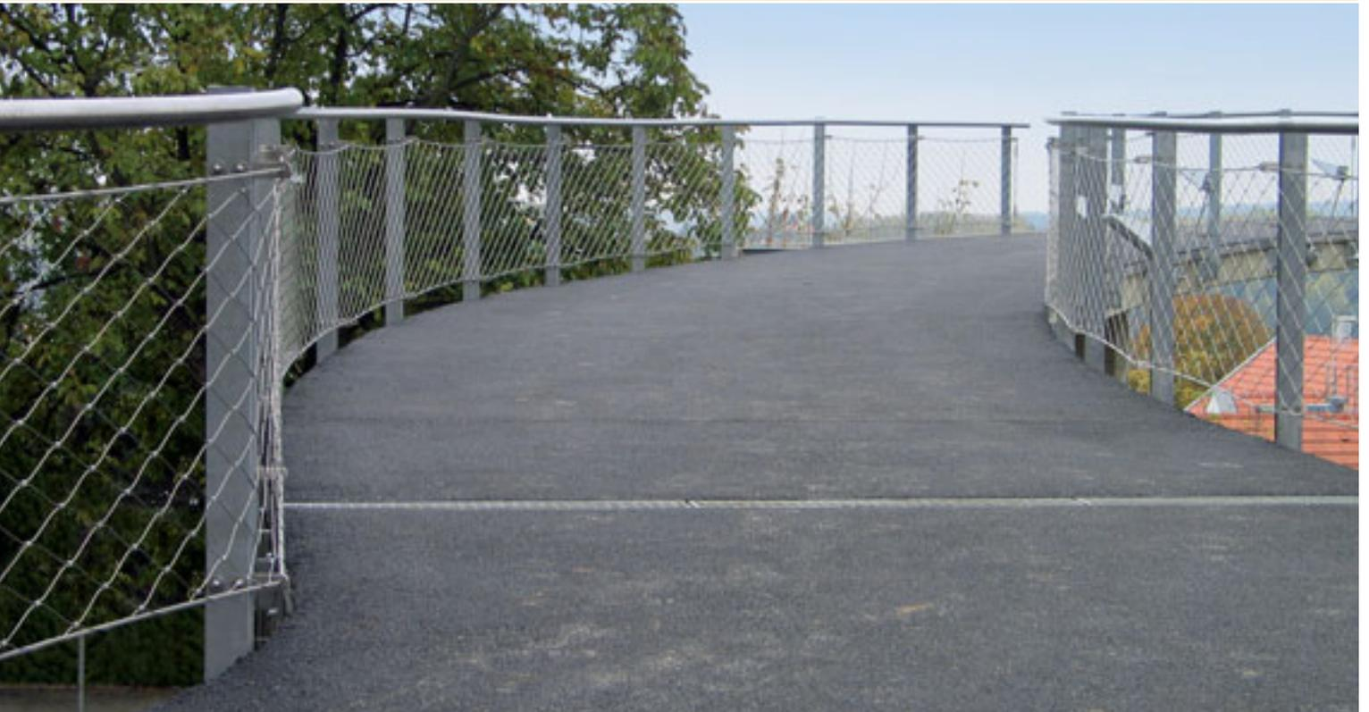
✧ Hubschrauberlandeplätze gehören mehr und mehr zum Standard für die Rettungsstellen von Krankenhäusern. In Mistelbach wird die runde Plattform von einem Netz aus X-TEND umringt, das maßgenau vorgefertigt und am Bau verspannt wurde. Die filigrane Konstruktion setzt sich fort als Geländerfüllung für Wege und Treppen.
