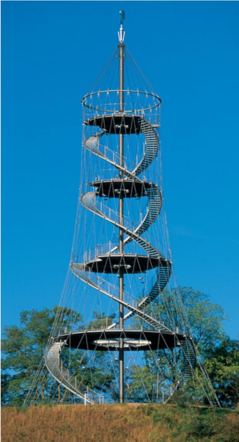
◇ Der 40 Meter hohe Turm der genialen Erfinder Schlaich Bergermann und Partner besteht aus einem Mast mit vorgespannter Seilstruktur, die durch intelligente Kräfteführung sich selbst, die Plattformen und Treppen hält. Zwei um 180 Grad gegeneinander angeordnete Stahltreppen erschließen das Wahrzeichen der Stadt Stuttgart, hier kommt das Edelstahlseilnetz X-TEND für die Geländer zum Einsatz.
