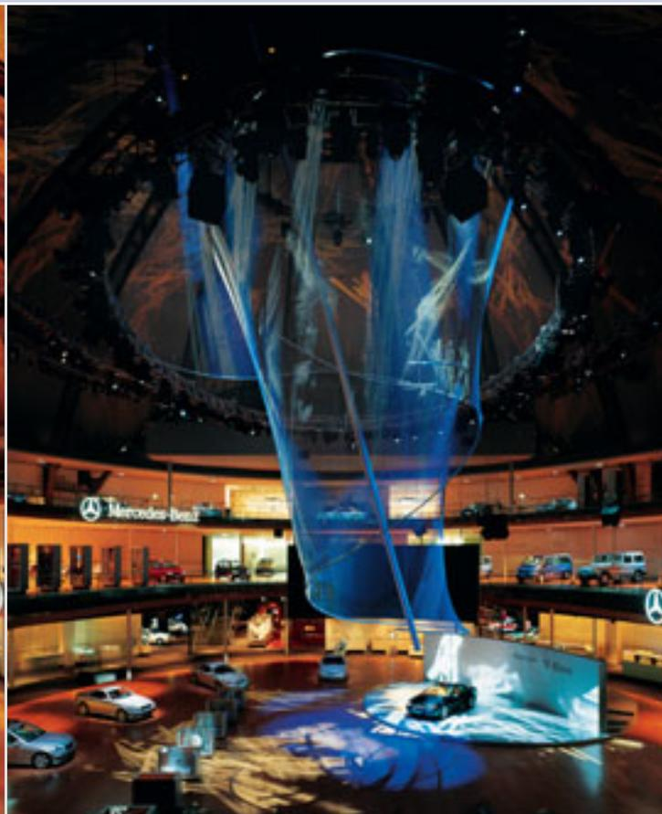
✧ Auf der Internationalen Automobil- ausstellung präsentierte Mercedes- Benz seinen Star unter der Kuppel der Festhalle. Über 20 Meter spannte sich das Netz zwischen zwei spiral- förmig gewendelten Randrohren im Durchmesser von 10 Metern. Um die Form faltenfrei zu verspannen, standen die langen Diagonalen der Maschen in der gesamten Figur vertikal. Dank exakter Berechnung konnte das maßgeschneiderte Kunstwerk auf der Messe schnell montiert werden.
