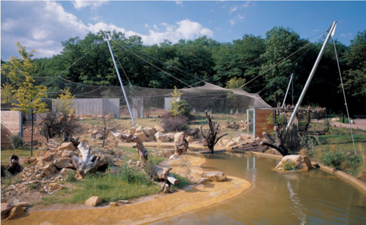
✧ Ein Mittelpylon und drei weitere außerhalb der Gehegefläche tragen den dreidimensional geformten X-TEND Zaun des nach oben offenen Reviers. So legen sich die Netzflächen völlig frei zwischen die horizontalen Ringseile, die über Abspannseile mit den Pylonen verbunden sind. Auf weitere Stahlprofile oder störende Stützen konnte zugunsten des uneingeschränkten Blicks verzichtet werden.
