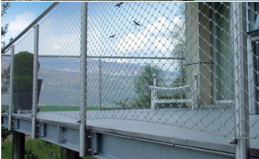
✧ Geografisch herausragende Positionen stellen an die Architektur besondere Anforderungen. Hier wird Wind zu Sturm, Schnee zur Eiswand und Sonne dehnt die Materialien. Statische Belastungen auf Druck und Zug sind die Folge der natürlichen Kräfteinwirkungen. Für dauerhaften Schutz sorgen gerade hier die Edelstahlseilnetze X-TEND, denn sie leiten Kräfte ab und können immer wieder in ihre Ursprungsgestalt zurückkehren.
