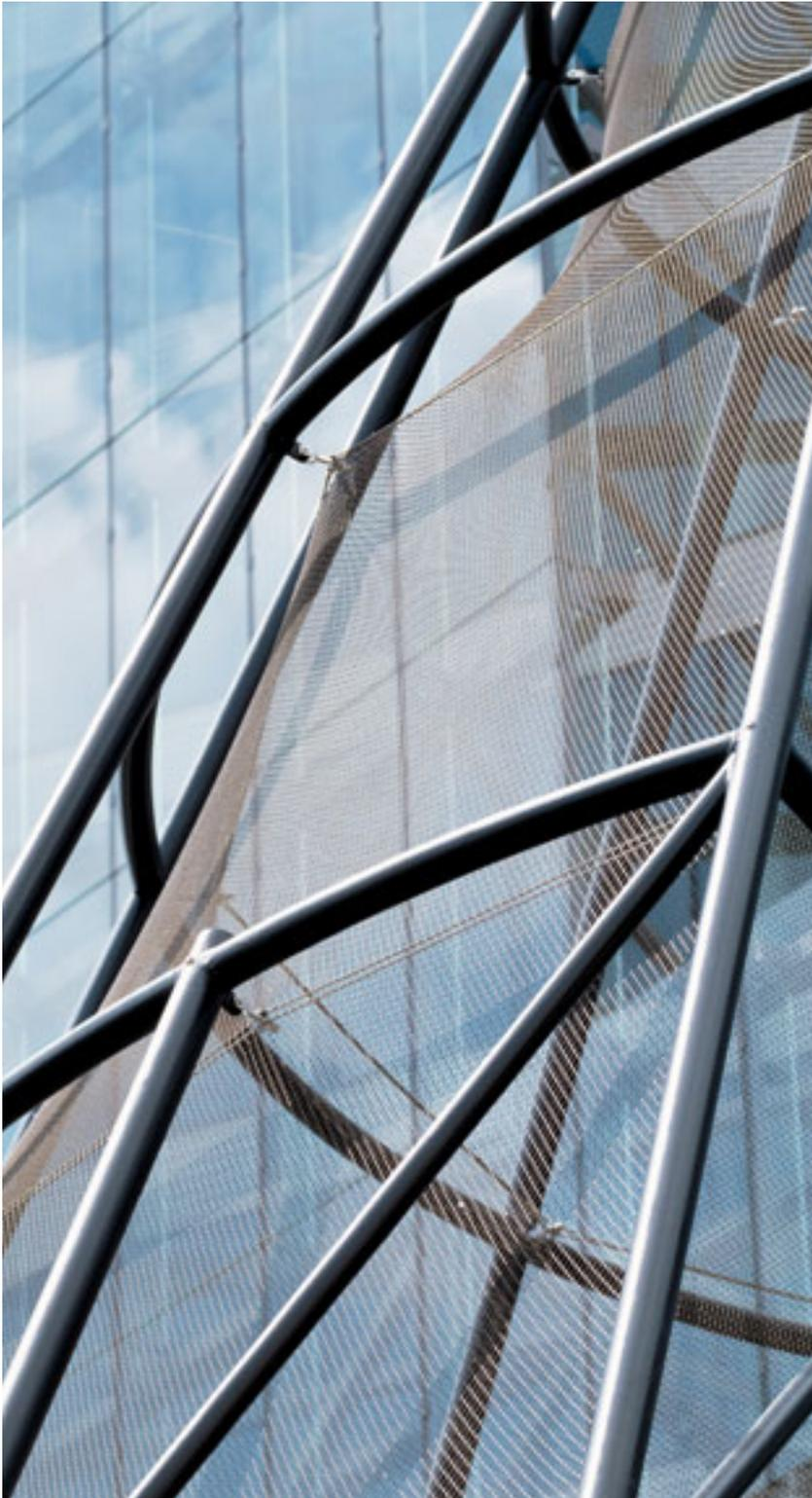
✧ Die Volieren im Berliner Zentrum ragen 12 und 24 Meter hoch. Zwei halbierte Kegel formen die Struktur. Geschlossen wird die gerasterte Hülle des beleuchteten Tragwerks mit X-TEND.
